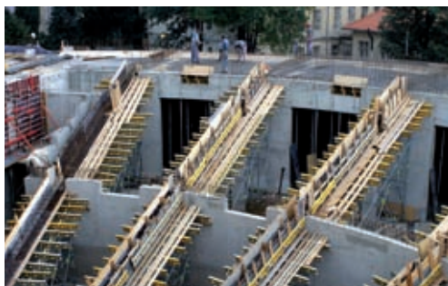
Konstrukce hlediště, srpen 2003
