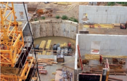
Betonování stěn, červenec 2002
